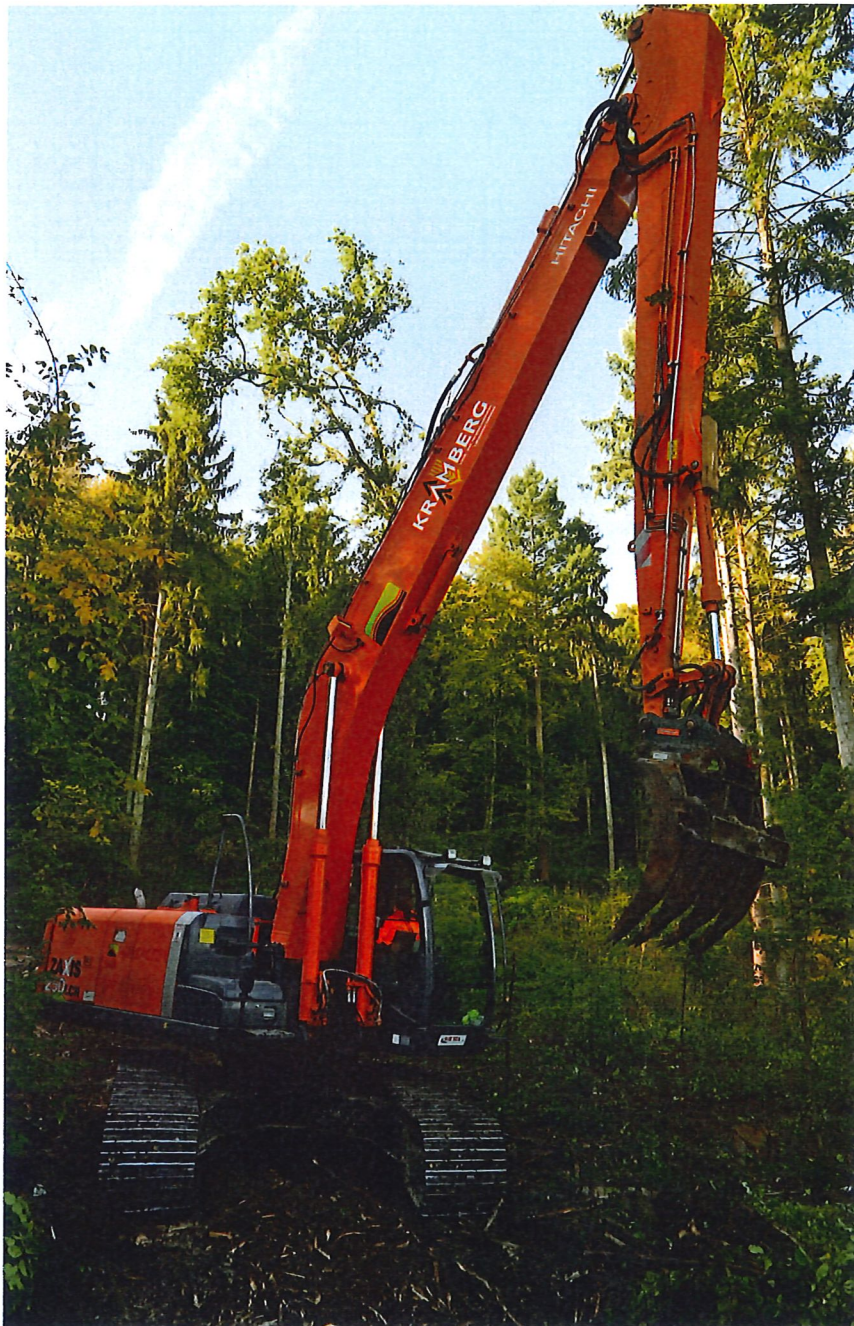
Der Stubbenroderechen ist jetzt anstelle des Reisigrechens montiert und erledigt die „grobe“ Arbeit.
